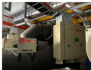
งานติดตั้งปรับอากาศขนาดใหญ่ (Chiller)
