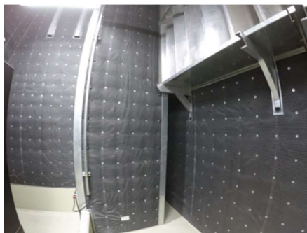
งานติดตั้งระบบห้องกันเสียง
