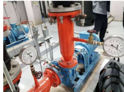
งานติดตั้งระบบบิมน้ำ (Pumping)
